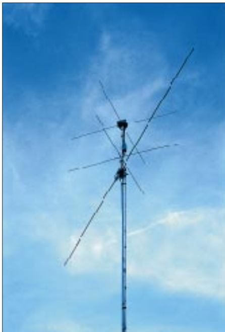
Bild 7: Die komplette Antennenanlage für 2 m und den beiden DV-27-Strahlern für das 10-m-Band
